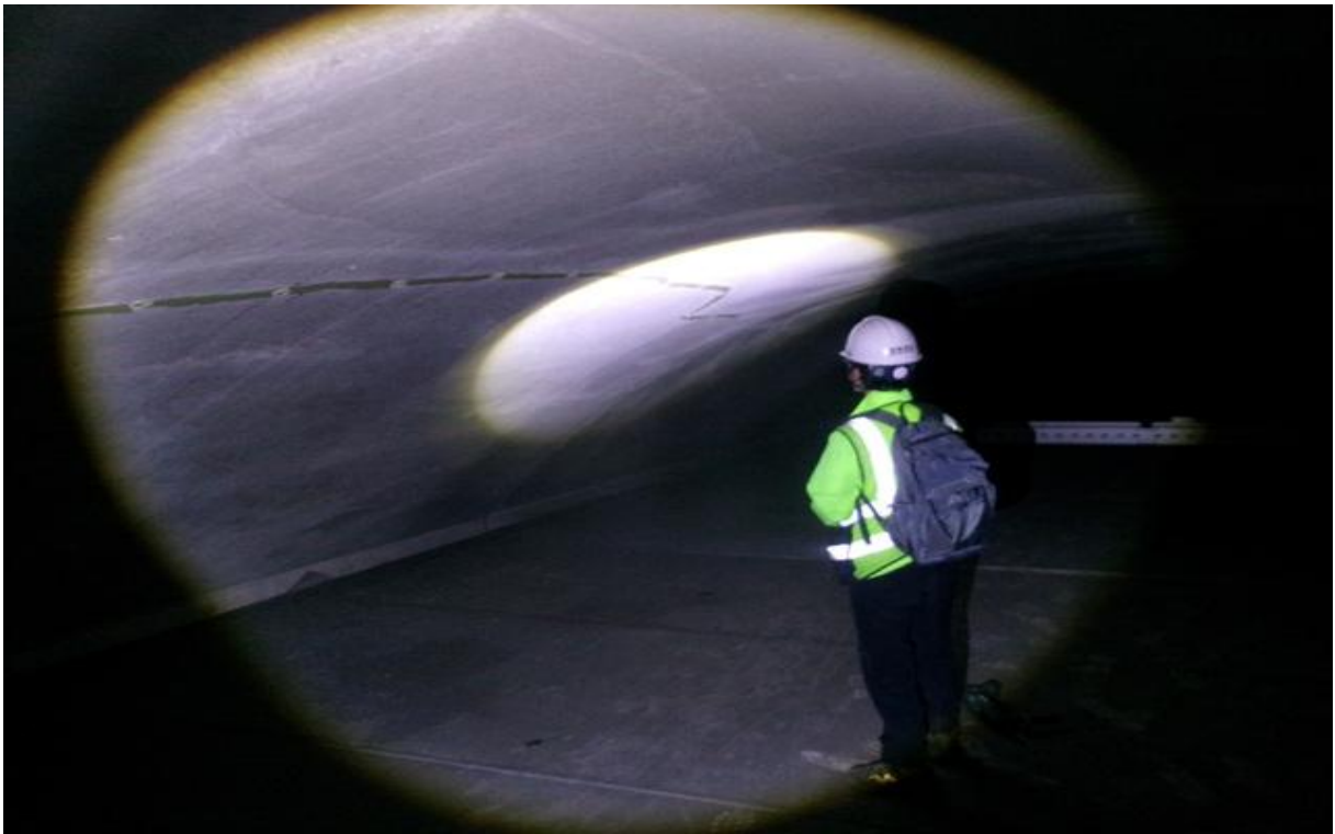
풍도슬래브 내부 이동점검
