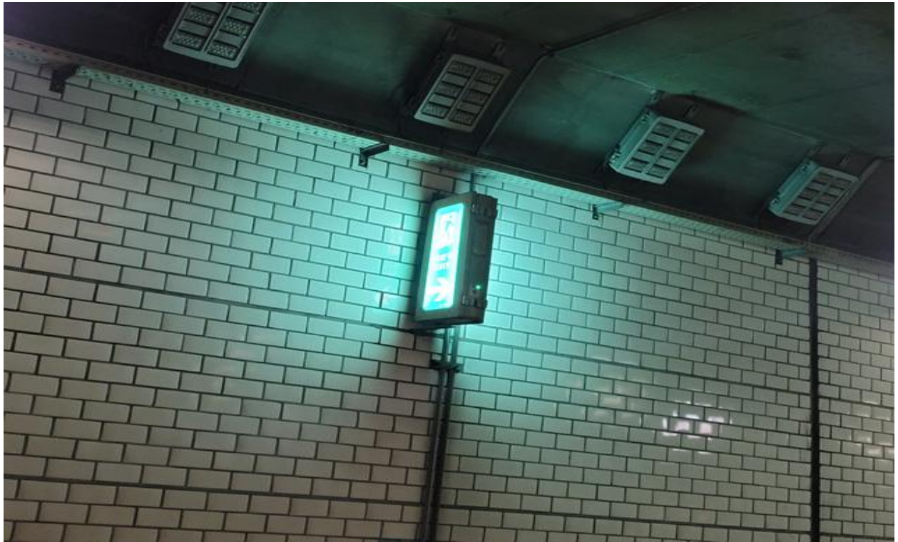
부대시설 S57 비상구 표지판 상태양호
