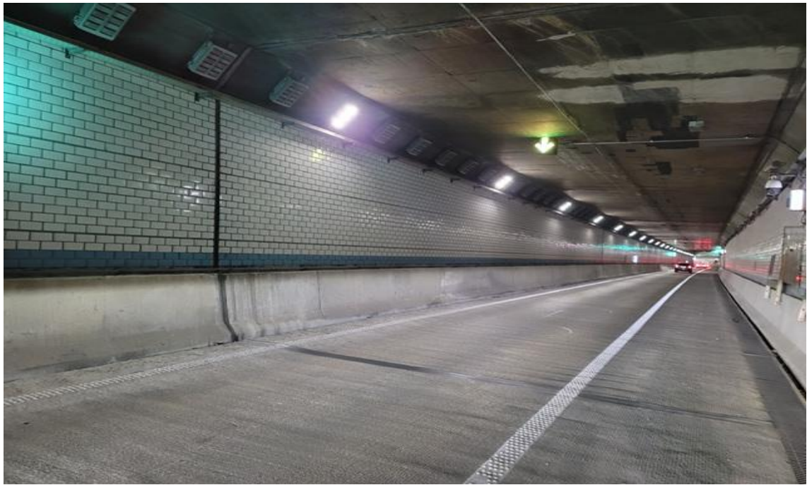
BOX구간 벽체 전경
