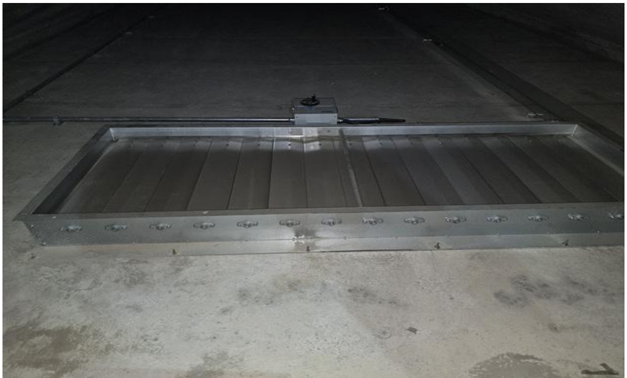
풍도슬래브 상면 S47 댐퍼 상태양호
