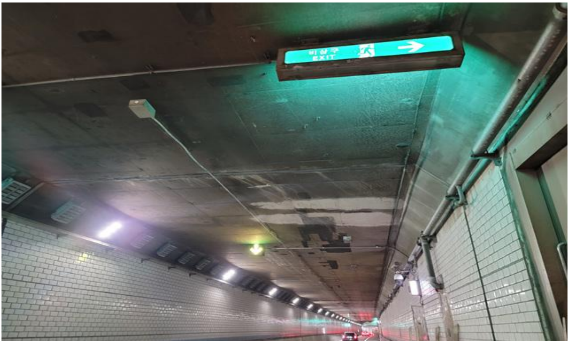
BOX구간 슬래브 전경
