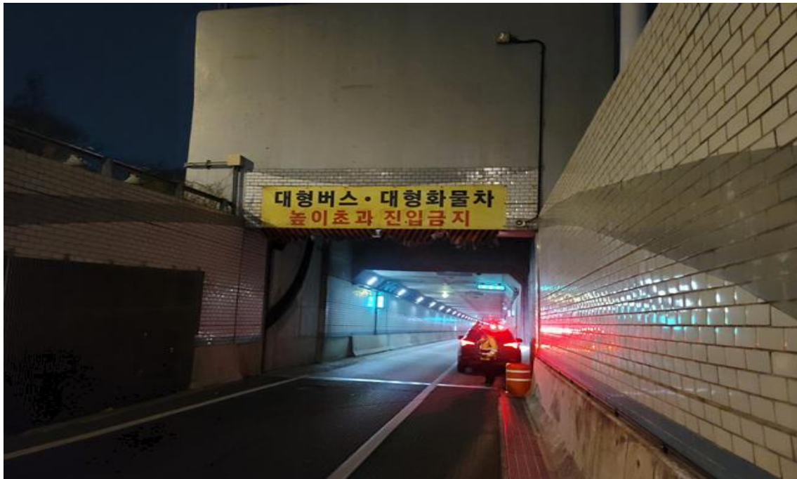
RAMP-D 갭문 전경
