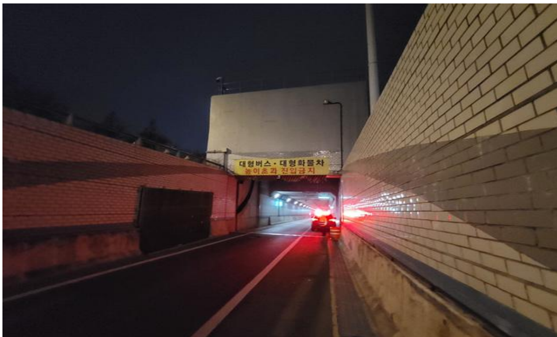
Ramp-D 갭문 진입부 전경
