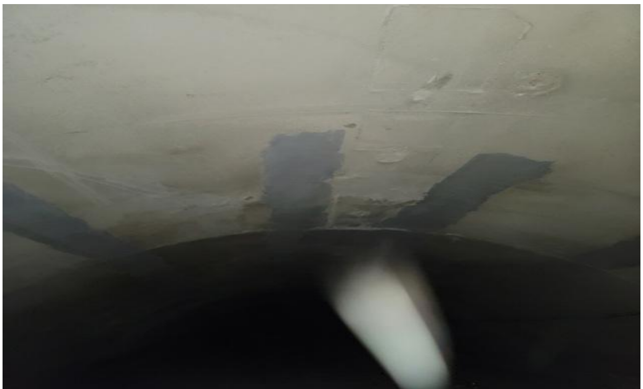
NATM구간 천단부 S50 상태양호
