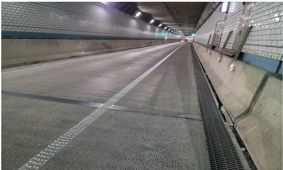
BOX구간 포장 전경
