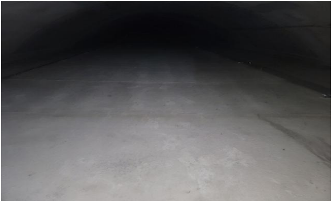
풍도슬래브 상면 S48 상태양호
