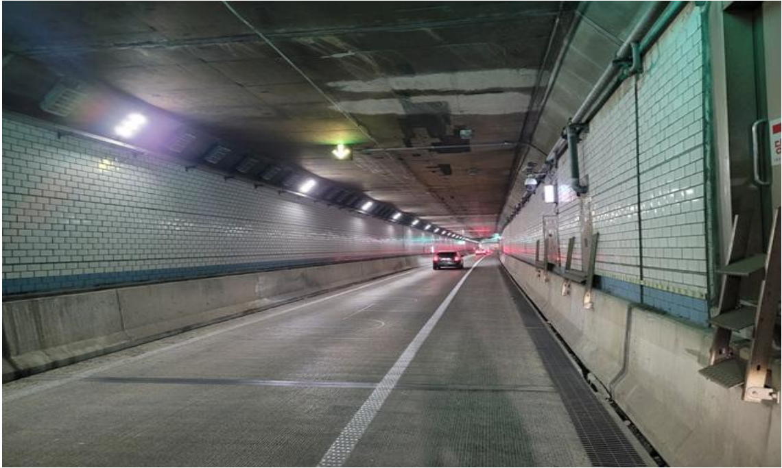
BOX구간 내부 전경
