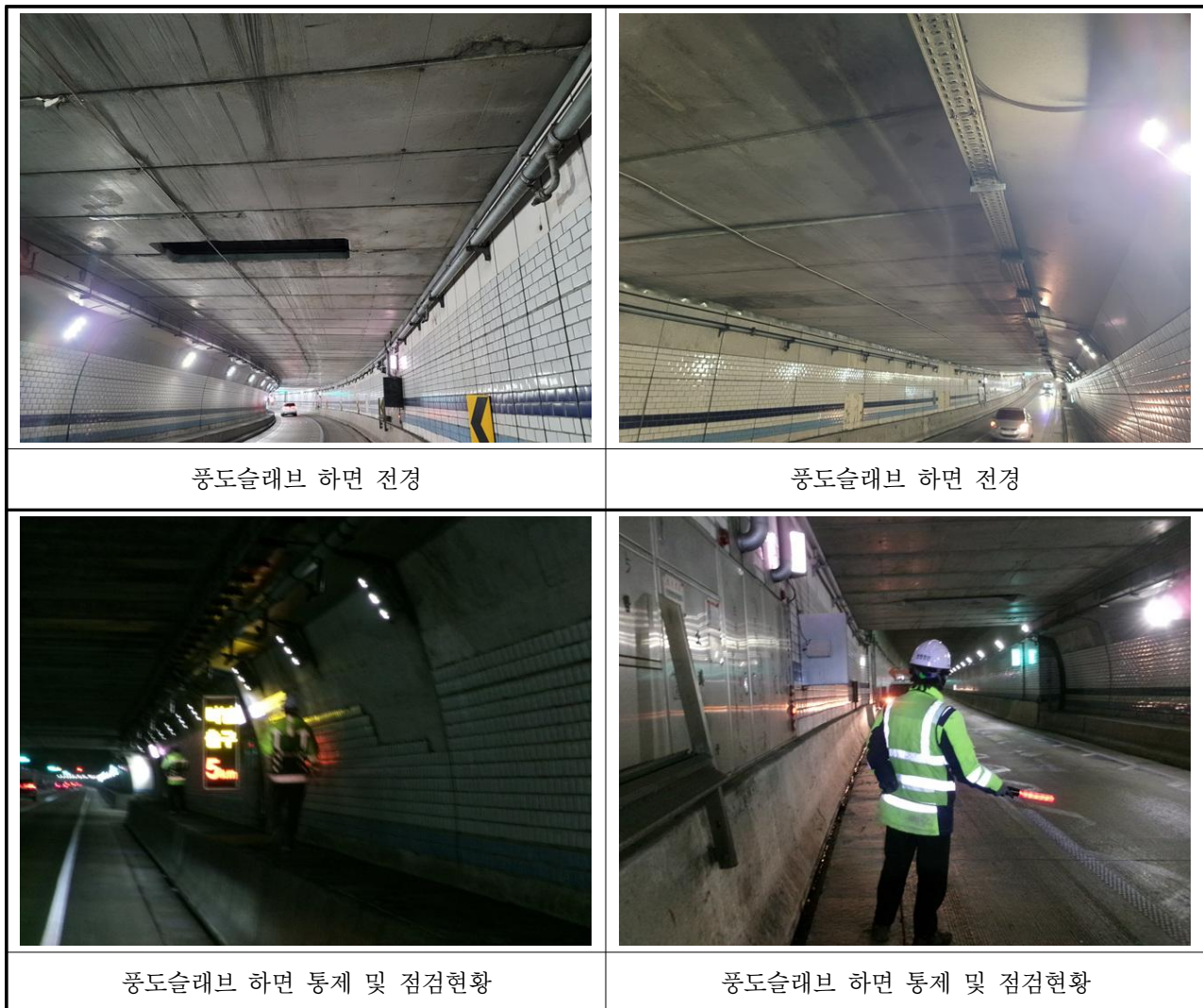
【사진 3.3.5】 풍도슬래브 하면 전경
