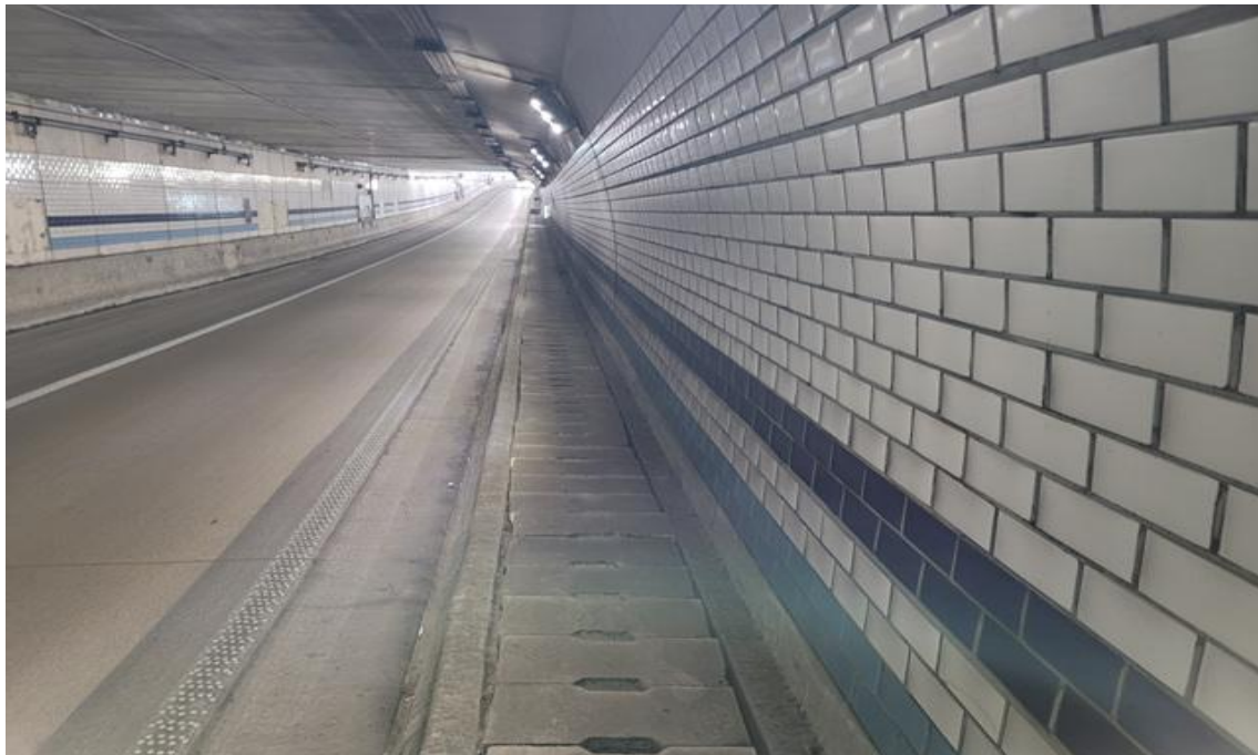
NATM구간 공동구 전경
